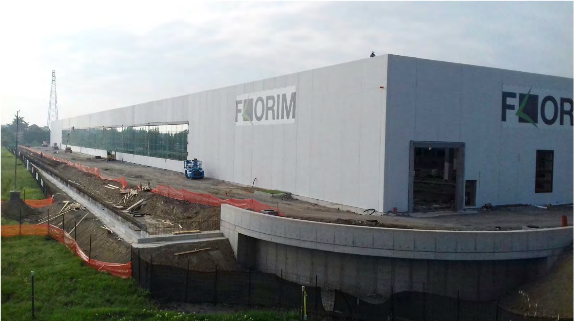
Realizzazione nuovo stabilimento FLORIM SPA in Fiorano (MO).
