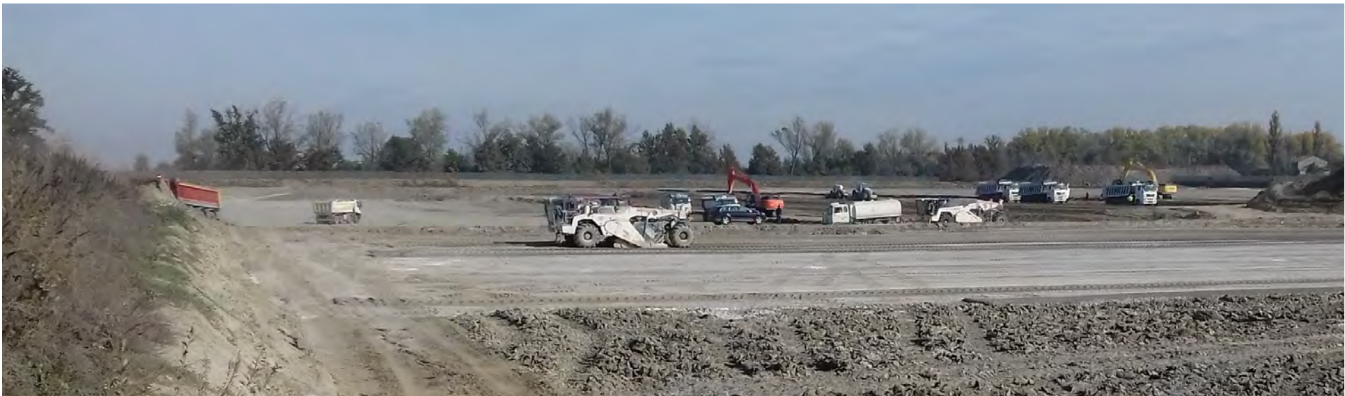
Attività estrattiva di argille, comprensivo di suo trattamento a calce per rilevati stradali, da cava di pianura a Parma (Italia)
