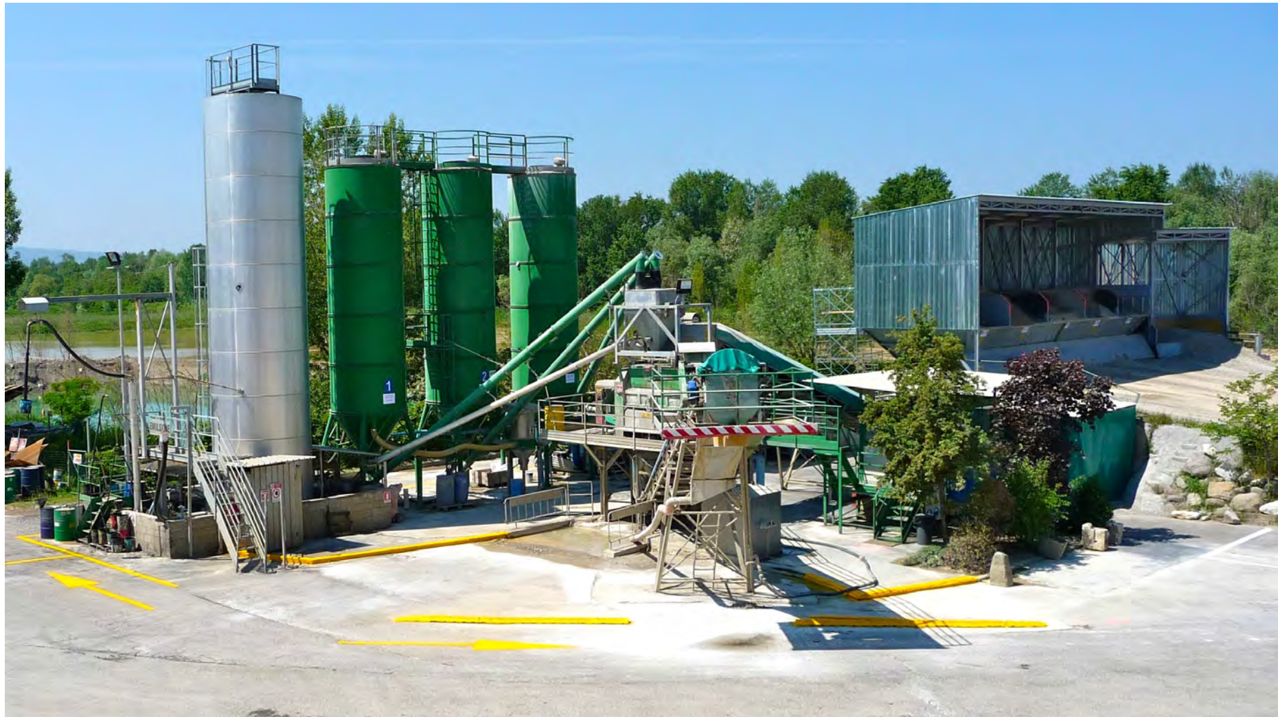
Impianti di produzione conglomerato cementizio a Modena, Italia. Concrete batching plant in Modena, Italy.
