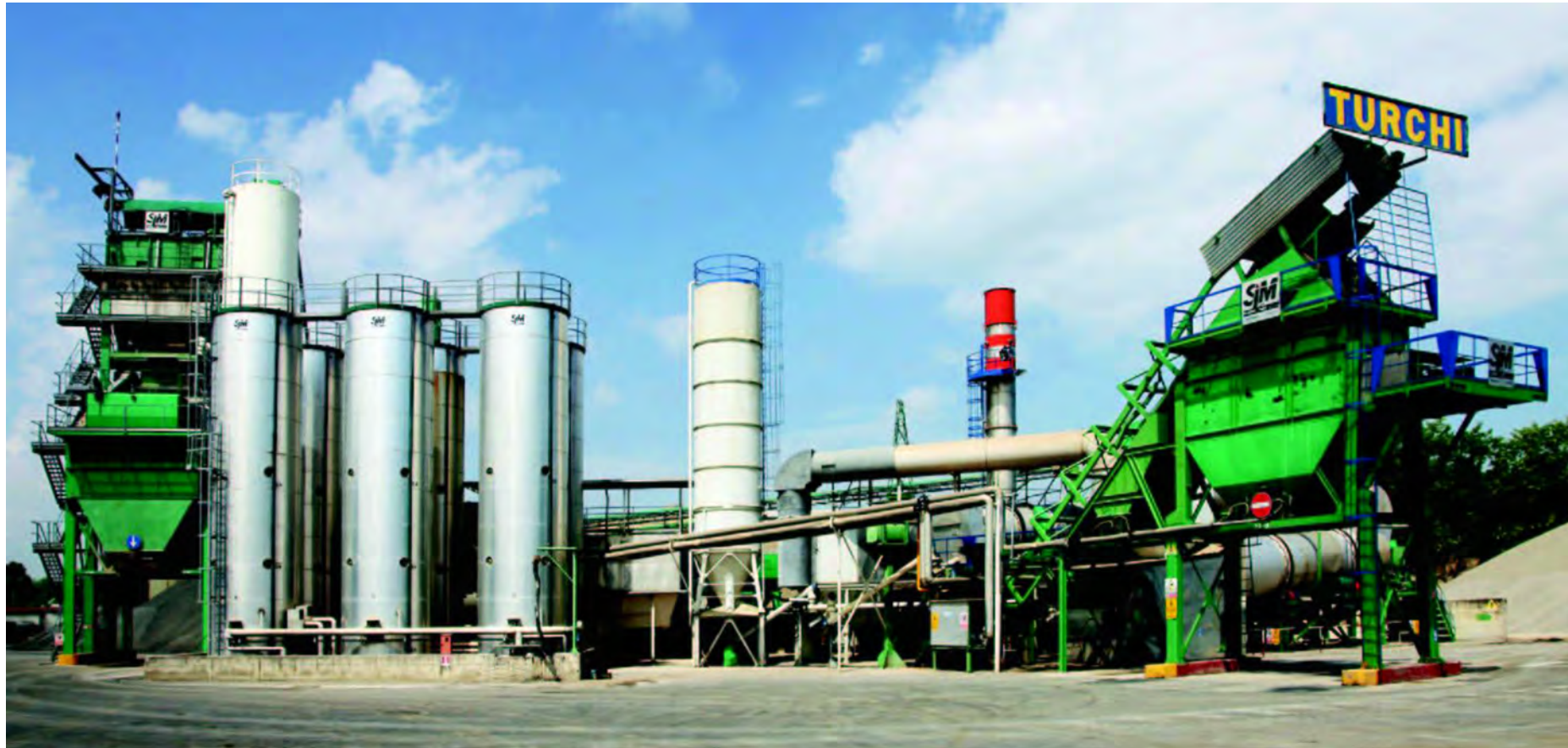
Impianti di produzione conglomerati bituminosi a Modena, Italia. Plants for the production of hot-mix asphalt in Modena, Italy.
