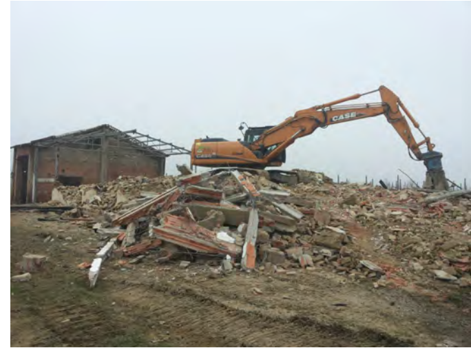
Lavori di demolizione
