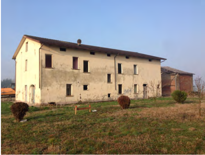
Ricostruzione di edificio rurale colpito dal sisma del Maggio 2012, Concordia (MO)
