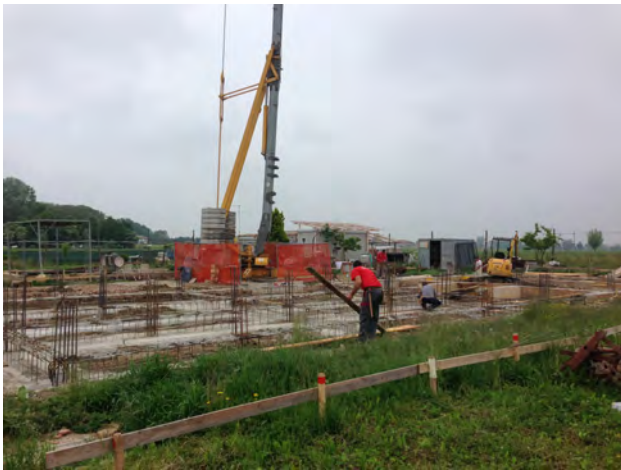
Realizzazione struttura antisismica
