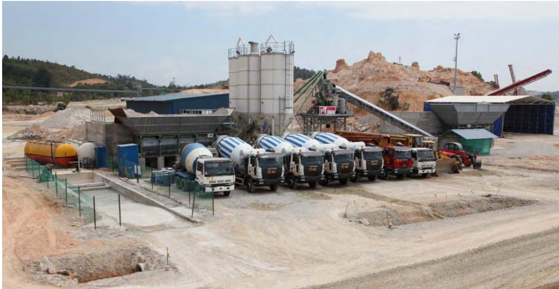
Impianti di produzione conglomerato cementizio a Karimun, Indonesia.
