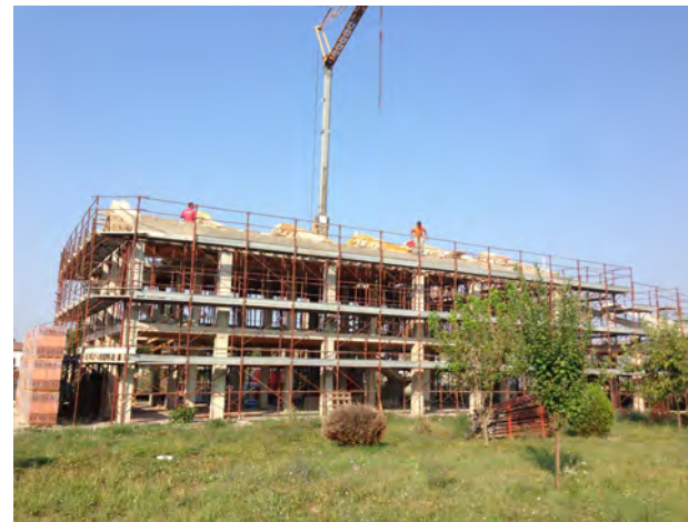
Realizzazione struttura in elevazione
