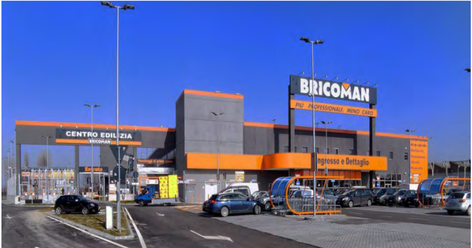
Realizzazione del nuovo punto vendita BRICOMAN a Modena (Italia).
