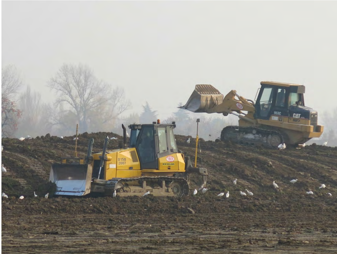
Realizzazione nuovo stabilimento FLORIM SPA in Fiorano (MO).
