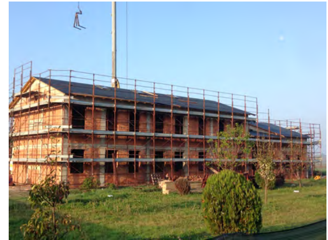
Completamento edificio al grezzo
