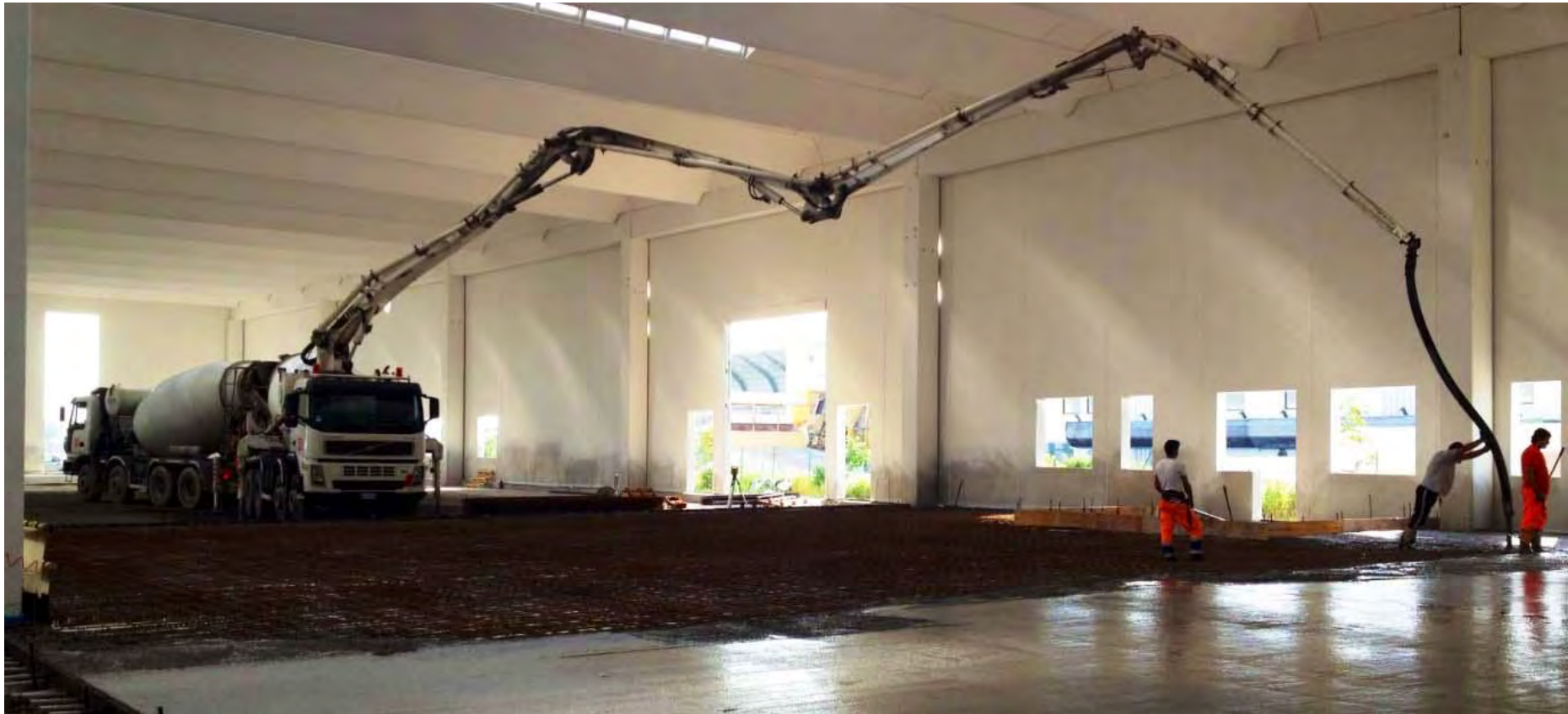
Realizzazione di pavimento industriale, Italia. Realization of industrial pavement, Italy.
