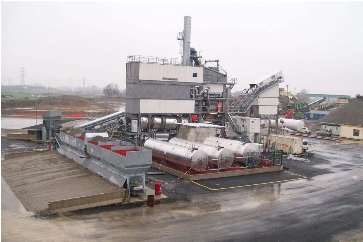
Figura 12: Panoramica degli impianti di confezionamento del conglomerato bituminoso.
