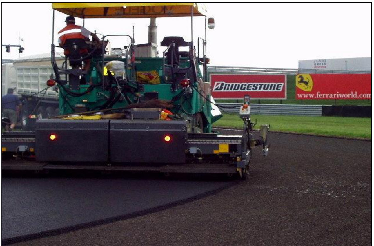
Figura 18: vibrofinatrici affiancate per la realizzazione del sottoballasto Fiorano Modenese, Modena
