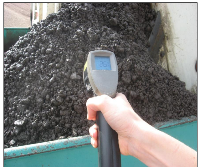
Figura 22: Temperatura di confezionamento e stesa del conglomerato bituminoso freddo (26/27°C)
