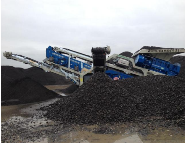
Figura 7: Impianto di frantumazione mobile per materiale proveniente da demolizione.
