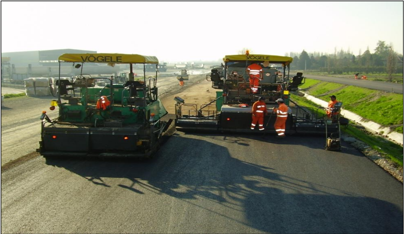
Figura 17: Vibrofinatrici affiancate nella realizzazione di subballast per Alta Velocità.
