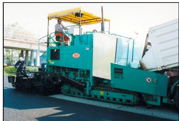
Figura 15-16: Allargamenti per realizzare una stesa uniforme senza giunti longitudinali e vibrofinitrice cingolata.
