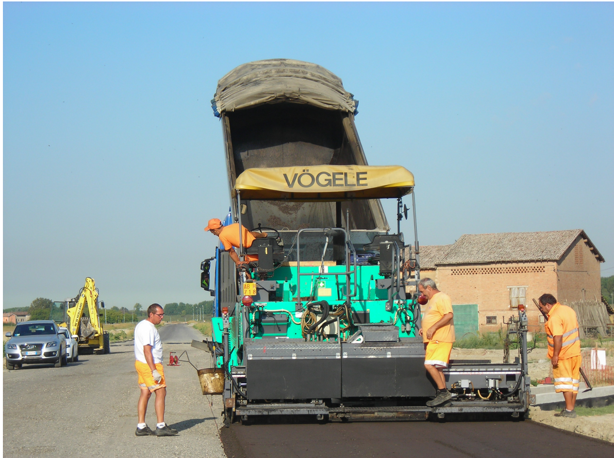
Figura 23: stesa del conglomerato bituminoso freddo 26/27°C
