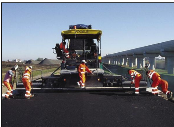
Figura 15-16: Allargamenti per realizzare una stesa uniforme senza giunti longitudinali e vibrofinitrice cingolata.
