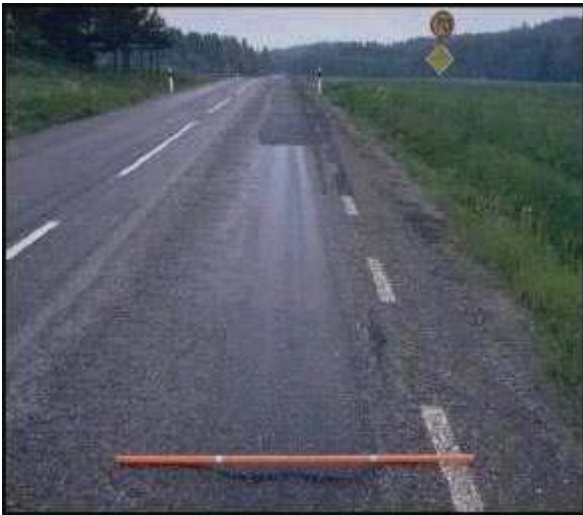
Figura 4: ormaia dovuta a ruote gemellate
