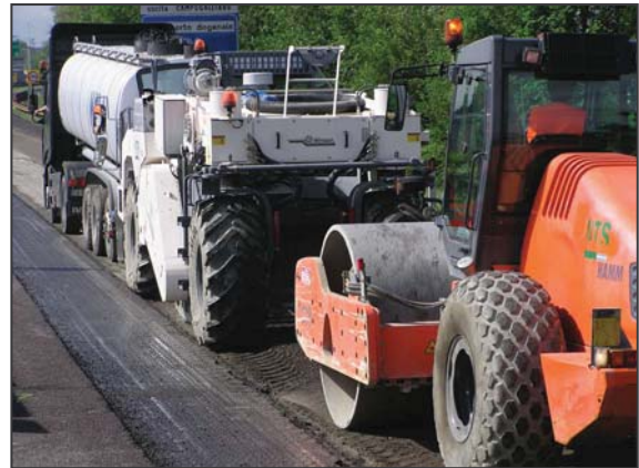
Figura 9: treno composto da cisterna emulsione, stabilizzatrice e rullo.
