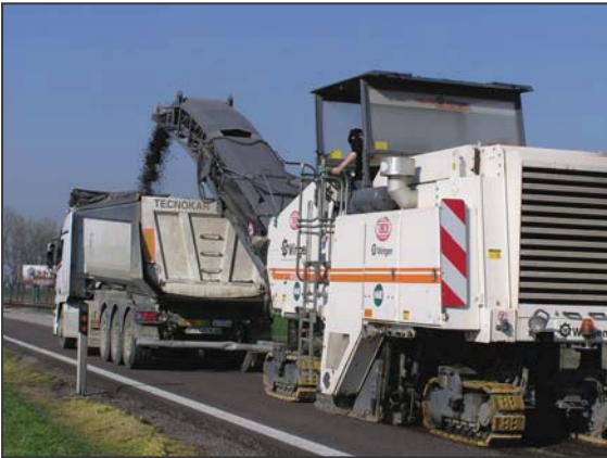
Figura 8: fresatura dei primi centimetri della pavimentazione da trattare.
