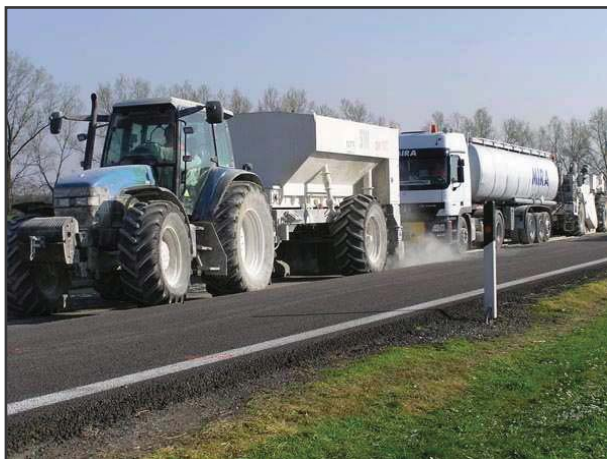
Figura 7: treno di riciclaggio formato da spandi legante, cisterna emulsione e fresa
