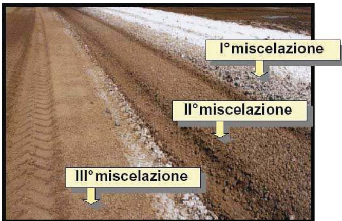
Figura 8: confronto tra diverse passate con pulvimixer
