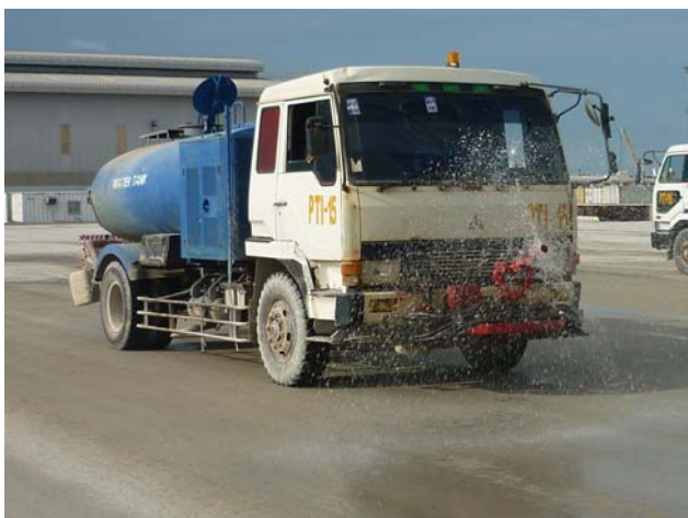
Figura 15: Fase di bagnatura
