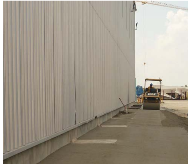
Figura 19: lavori a mano – fase di rullatura e finitura
