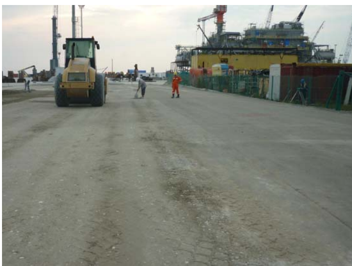
Figura 13: Misto cementato prima dello spolvero
