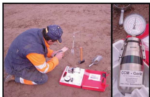
Figura 10: Controllo dell'umidità post-miscelazione
