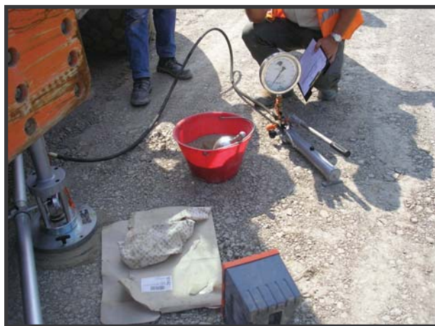
Figura 12: Prova di carico su piastra
