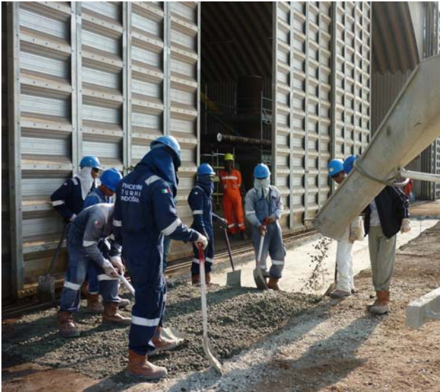
Figura 18: lavori a mano – fase di getto
