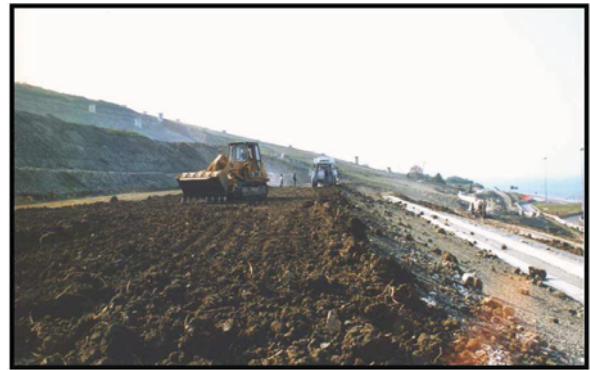
Figura 3: terra di riporto per strati di rilevato
