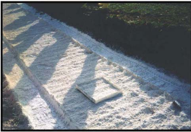
Figura 2: controllo della quantità di legante dosata
