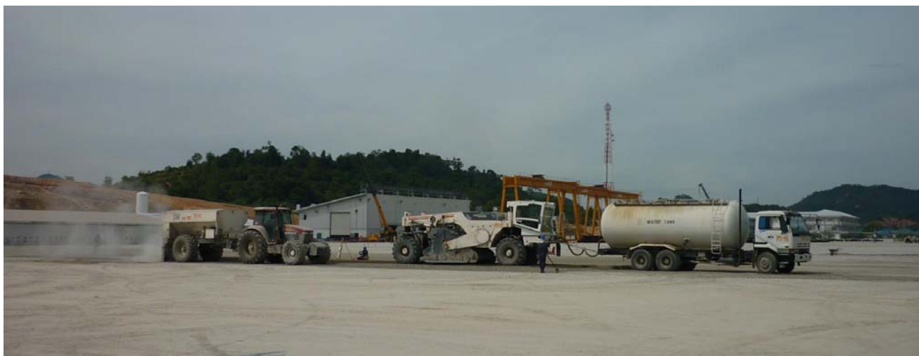
Figura 12: Treno stabilizzazione in azione
