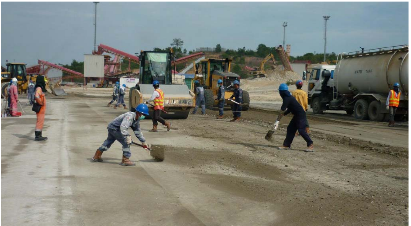
Figura 14: personale locale durante le operazioni di spolvero
