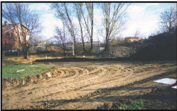
Figura 2: esempio di scotico per stabilizzazione in sito
